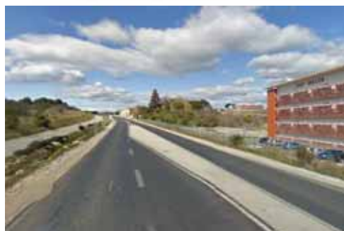
Vue de la RD 127 depuis l'entrée Sud de la commune de Grabels
