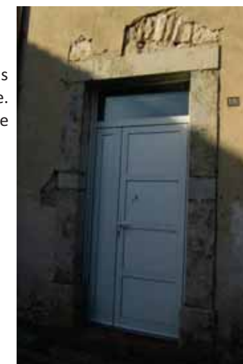
Détails : des interventions architecturales parfois en contradiction avec l'esprit du lieu (pvc)
