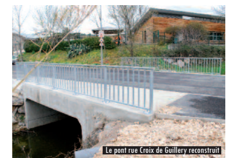
Le pont rue Croix de Guillery reconstruit
